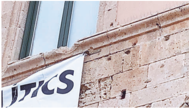
Detall de l'ancoratge que s'ha col·locat (Foto: JG -El Mònic)
