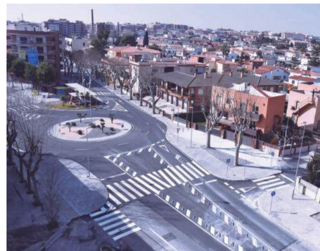
La rotonda a l'alçada del carrer dels Pescadors s'ha construït aquest mandat (Foto: A. Fusté- Aj. de Torredembarra)
